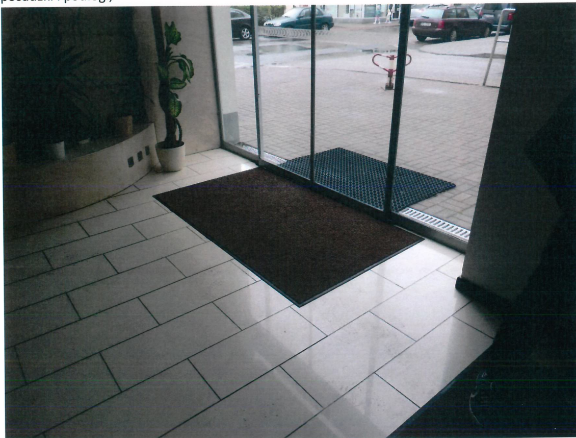
Fot.[26] Wykończenie podłóg wewnętrznych – stan dobry.
