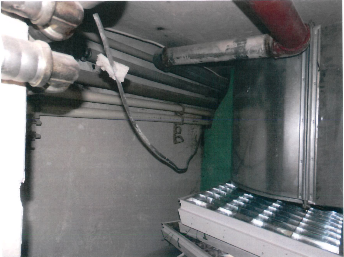
Fot.[30] Przejścia instalacyjne – stan średni.
