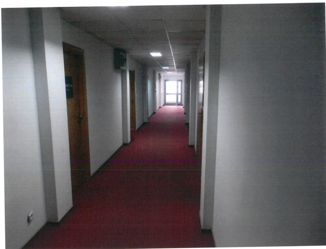
Fot.[19] Tynki wewnętrzne – stan dobry.
