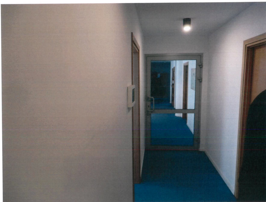
Fot.[27] Wykończenie podłóg wewnętrznych – stan dobry.
