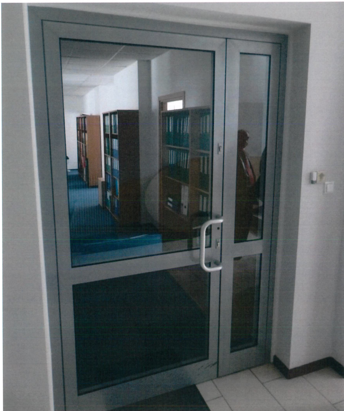
Fot.[24] Drzwi wewnętrzne – stan dobry.
